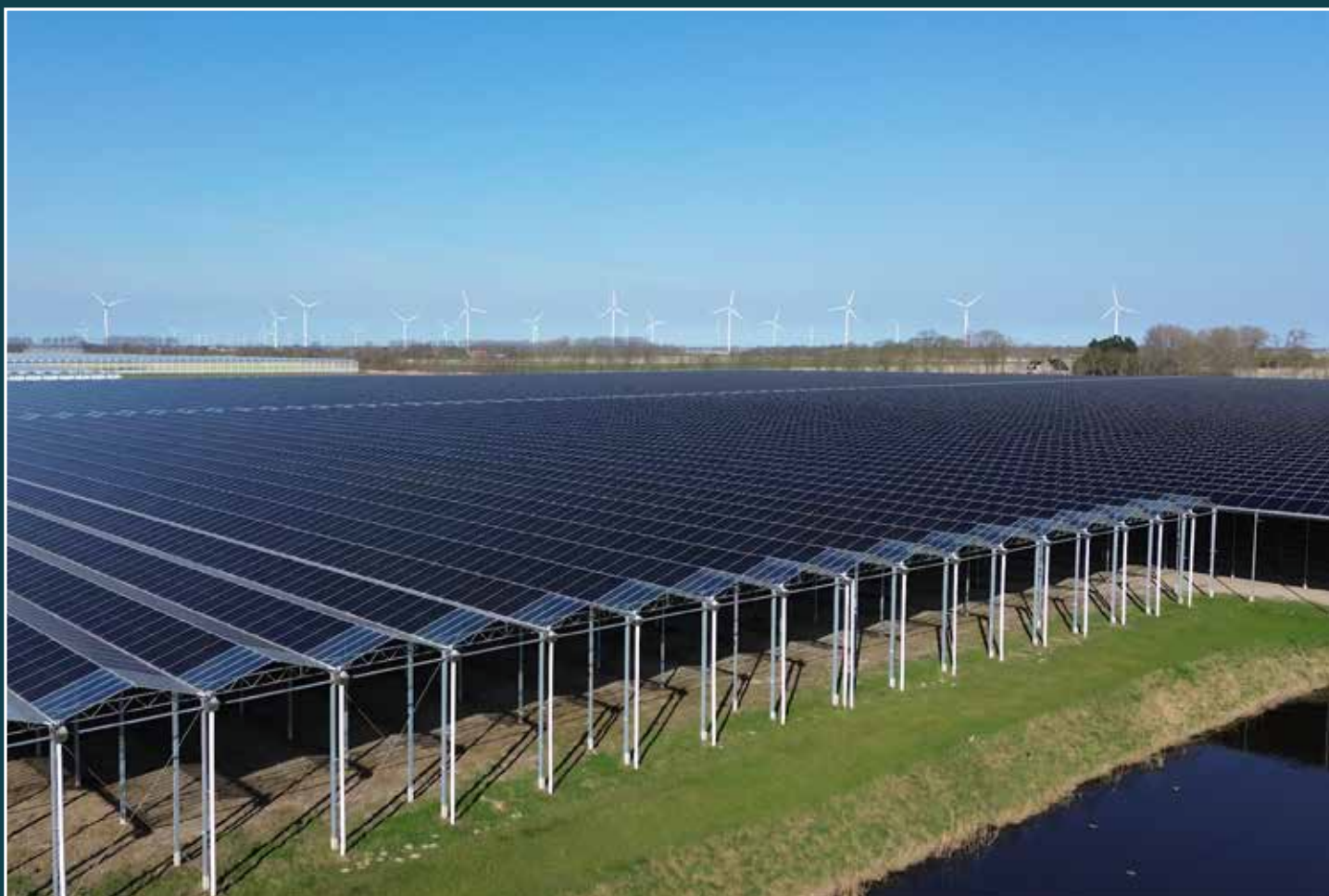
'De illegale zonnekas van 16 ha aan de Medemblikersluisweg'
