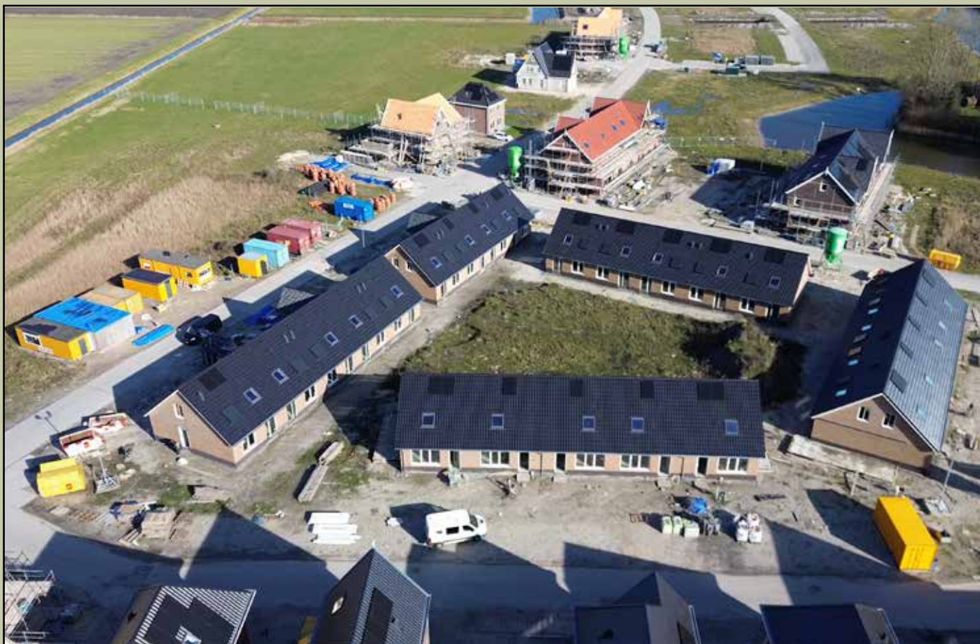
'Woningbouw in 't Veld-Noord'
